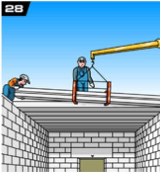
**28.** Для разгрузки и монтажа плит перекрытий используют специальные траверсы. Разгрузка и монтаж плит перекрытий выполняется при помощи специальных траверсов.
