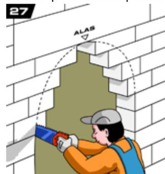
**27.** Оконные и дверные проемы сложной формы легко вырезаются ручной пилой.
