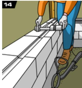
**14.** Первый и каждый 4-й ряд кладки рекомендуется армировать. Для этого прорезаются штробы (25x25) с помощью ручной или электрического штробореза. Необходимо удалить пыль из штробы, используя сметку или фен. Перед укладкой арматуры штроба заполняется клеем.
