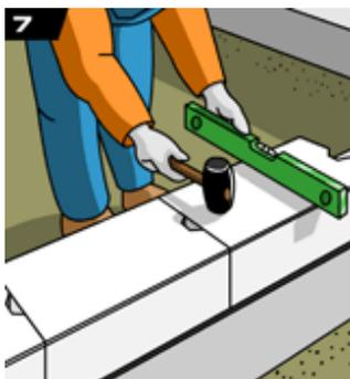
**7.** Установка каждого блока контролируется по уровню и шнуру причалке. Для корректировки кладки блоков используется резиновая киянка.
