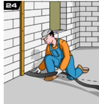
**24.** В основании внутренних стен необходимо укладывать мелкопористую битумную полимерную ленту. Для улучшения звукоизоляции в месте примыкания к боковой стене рекомендуется устанавливать уплотняющую ленту из мелкопористого материала.
