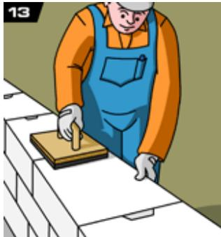
**13.** После укладки очередного ряда блоков поверхность кладки выравнивается с помощью терки. Между соседними блоками не должно остаться перепадов уровня. Мелкие загрязнения и пыль удаляются щеткой.
