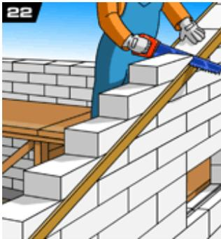
**22.** Наклон торцевой кладки выполняют при помощи ручной пилы и терки для шлифования.
