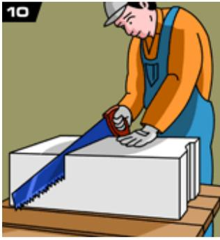
**10.** Доборные блоки легко выпиливаются при помощи ручной пилы. Для обеспечения точности резания блоков и соблюдения прямых углов применяется угольник. Использование для распилки электрической ленточной пилы гарантирует высокую точность подрезки блоков.
