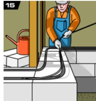
**15.** На углах стен штробы делаются с закруглением. Для армирования используют стальные прутки диаметром 8 мм, которые сгибают по месту, используя специальный инструмент или ручные приспособления. Прутки вдавливаются в штробы. Клей должен полностью покрывать арматуру. Излишки клея удаляются.
